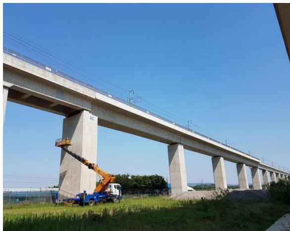
교량 측면 전경
