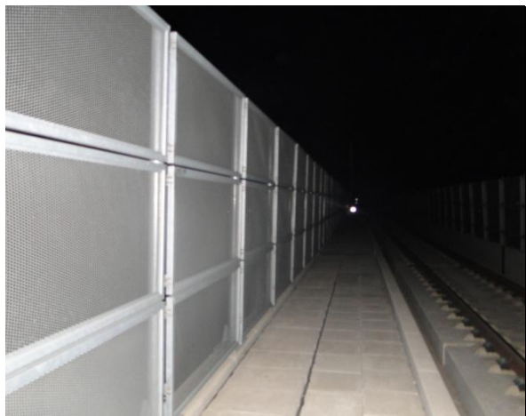
교량 상부 전경
